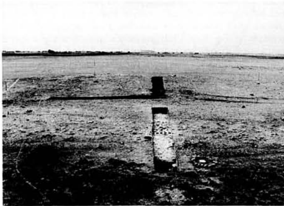
136 Östlicher Kanal bei Tall Šeh Hamad; Westprofil mit Aufschüttungsschichten des Dammes; Aufnahme 1984 von Norbert Grundmann
